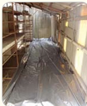
폴리에틸렌 시트로 작업장 바닥 보양
