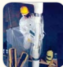
수직부 해체 작업
