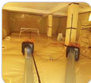
음압기를 설치하여 작업
